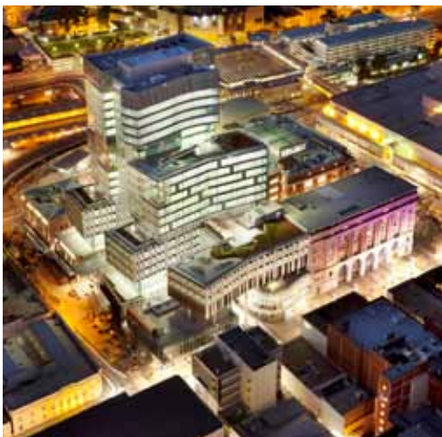
Vier Spuren mit OptiStile und vier AutoSec-Türen wurden im one40william in Perth installiert.
